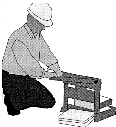
Рисунок 23 – Изготовление дополнительных элементов с помощью гильотины
